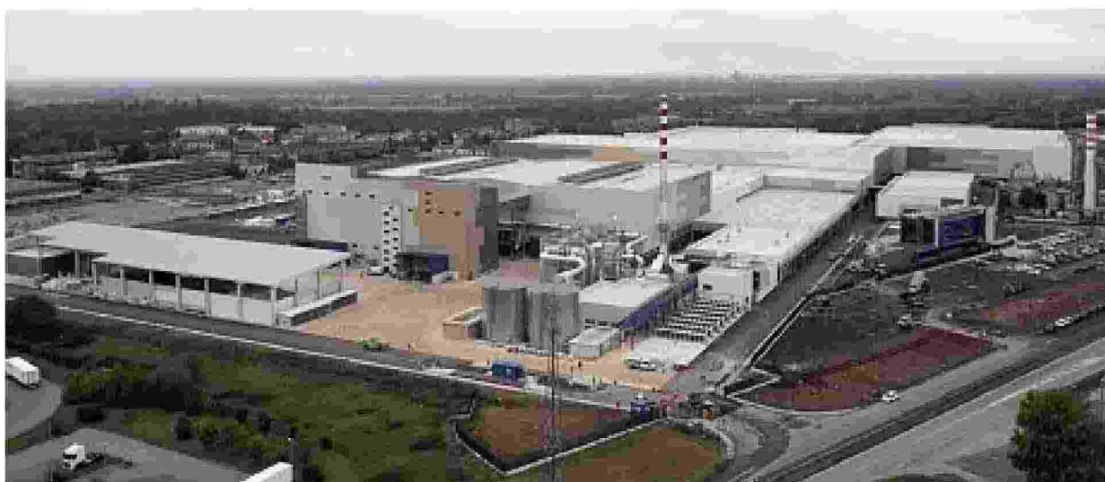
Impianto Vetropack a Boffalora sopra Ticino, su un'area industriale di 347.000 m 2 con 160.000 m 2 edificati e 35.000 m 2 di parco ad uso pubblico
